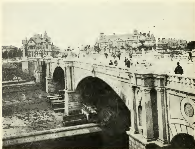
Nippon Bridge, Dairen
