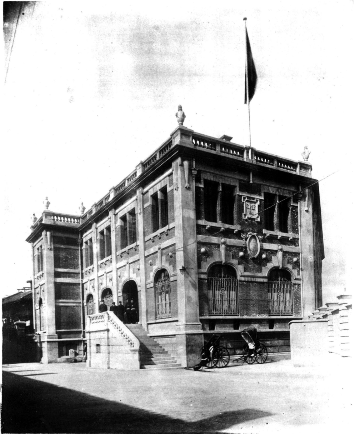
POSTE CENTRAL DE POLICE
