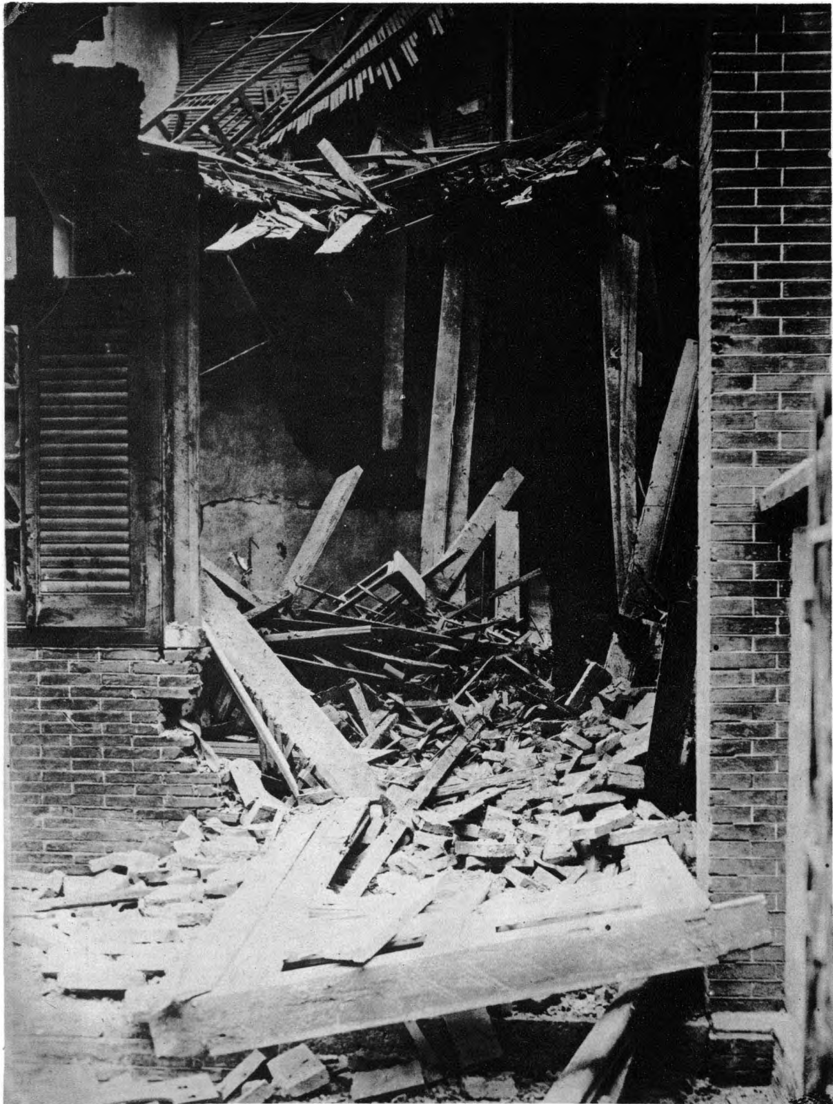
MAISON DÉTRUITE PAR L'EXPLOSION DE BOMBES le 16 Septembre 1915 Rue Paul Beau, No. 6, Cité "Sing Ming Li"
