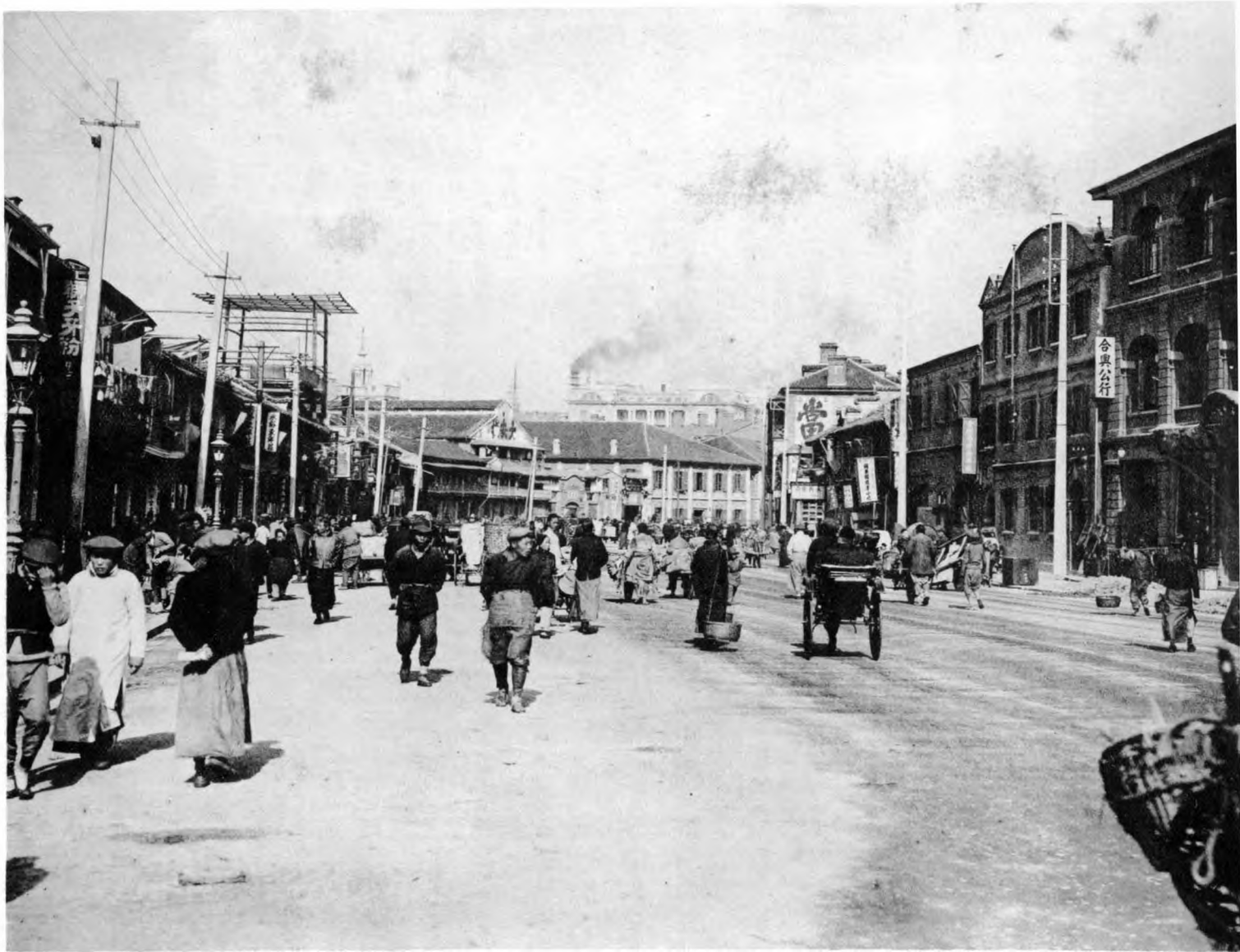
AVENUE EDOUARD VII (ANCIENNEMENT QUAI DU YANG KING PANG) Partie comprise entre les rues Petit et Montauban
